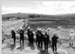
工事現場、見学のようす
