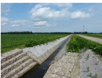
除礫した石を再利用した排水路整備
