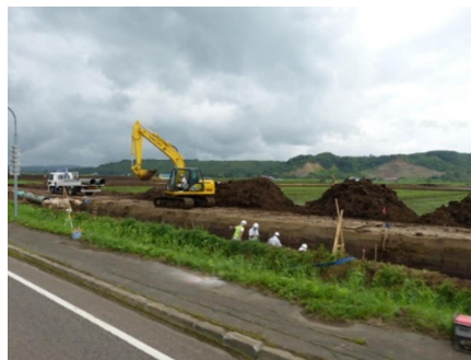
用水路の施工状況
