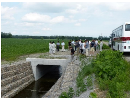
除礫した石を再利用した排水路整備
