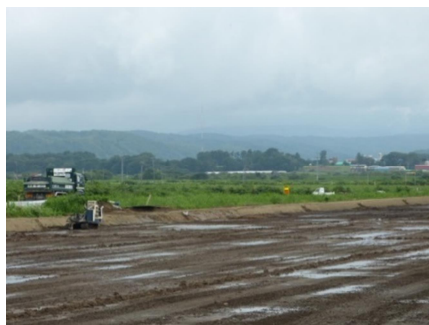
水田の畦畔の施工状況
