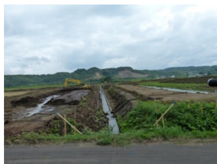
附帯明渠の状況
