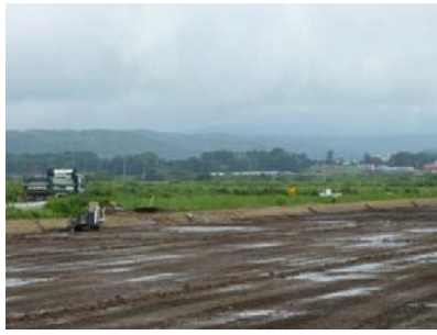
水田の畦畔の施工状況
