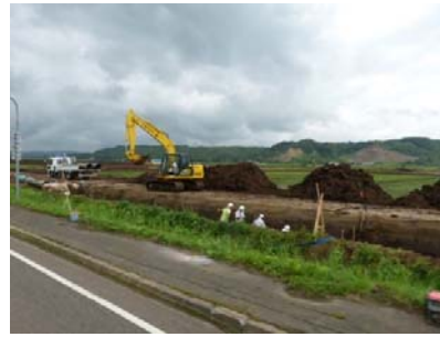
用水路の施工状況
