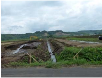
附帯明渠の状況
