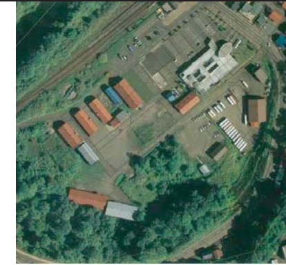
倉庫群航空写真
