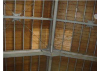
4. 断熱がされていない鉄骨柱
