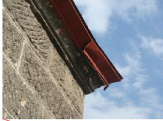
2. 沈下している南東の屋根面
