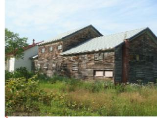
1. 欠損している軒天の仕上げ材
