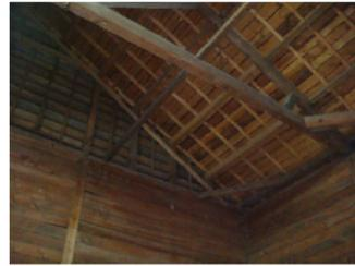
2. 欠損している壁面の仕上げ材
