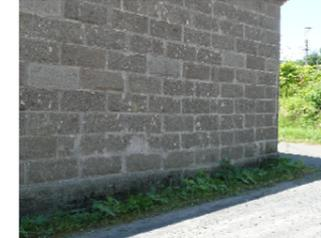
※基礎の沈下により建物に歪みが発生し、壁面に多数のひび割れが見受けられる。南東部屋根の沈下もこの影響を受けているものと考えられる。
