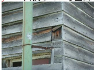
4. 欠損している腰壁の鋼板
