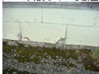
5. 腐食により開口している床面
