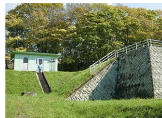
市街地区浄水場
