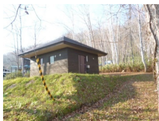
曽我地区第2浄水場
