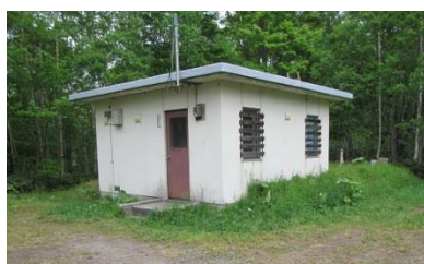
里見地区配水池
