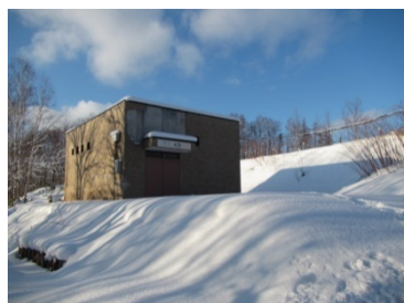
福井地区浄水場
