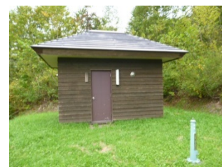
曽我地区第2配水場
