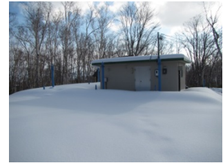
ニセコ地区浄水場
