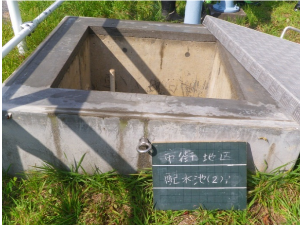
屋外の配水池人孔
