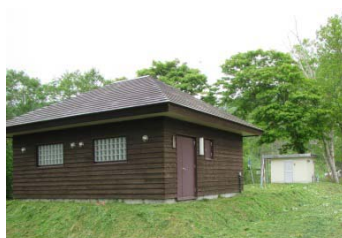
曽我地区第1浄水場
