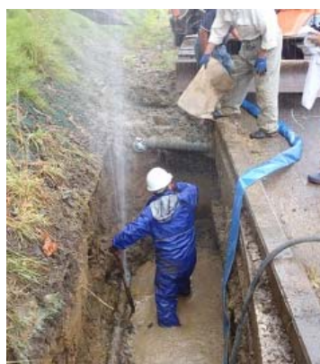
漏水修繕工事（宮田里見地区）
