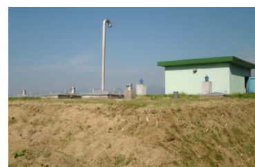
小花井地区浄水場
