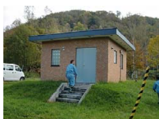
近藤地区浄水場
