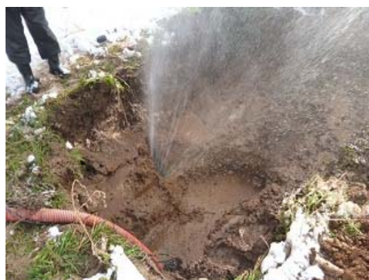
漏水修繕工事（曽我地区）
