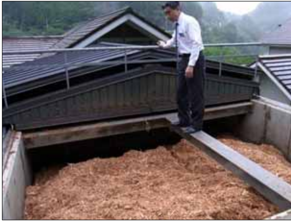
屋根が可動しチップを貯蔵するコンクリート製のサイロ室
