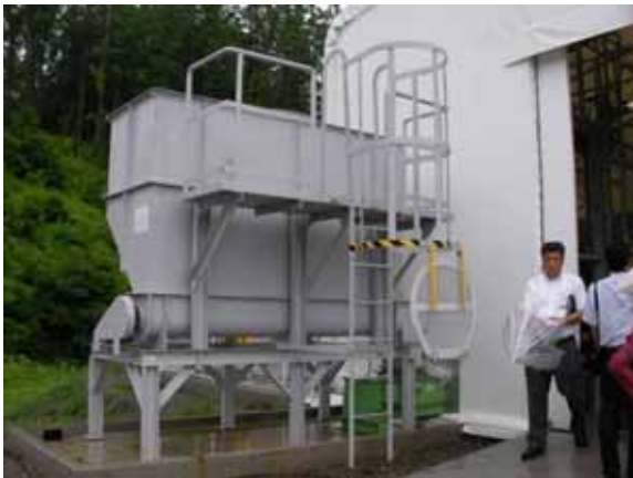
原料を投入し一時貯蔵する燃料ポッパー
