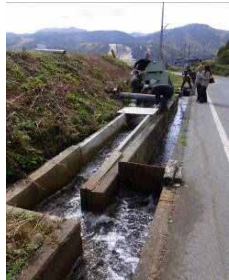
農業用水を利用してマイクロ水力発電を 実施している
