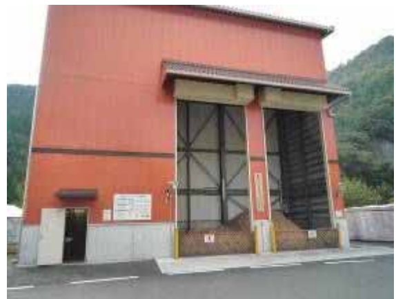
バイオマス発電所全景
