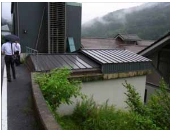
サイロ室の全景
