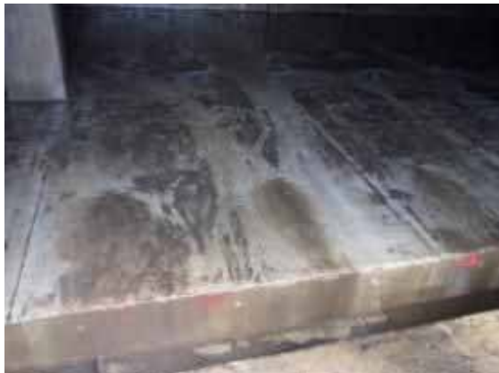
水が排水溝に流れるようになっている
