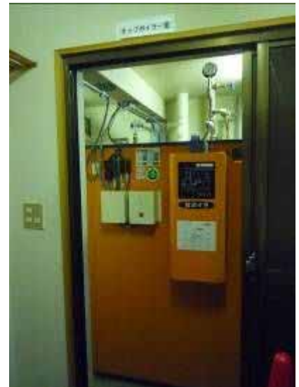
浴室を改修してボイラーを設置
