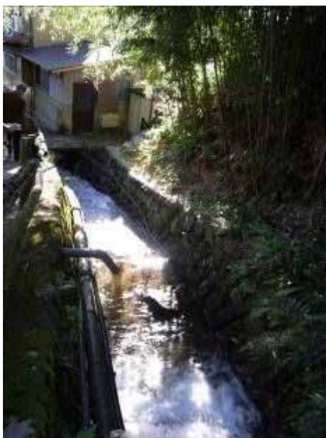
用水から水圧管で水を引いて、落差で加圧 噴射してタービンを回している
