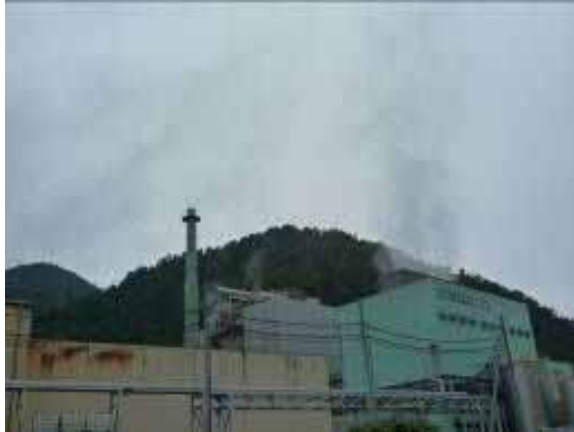
川辺バイオマス発電全景
