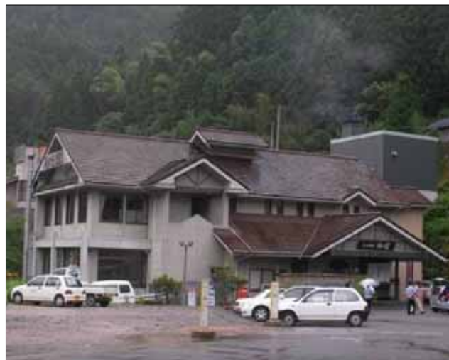
月ヶ谷温泉 月の宿の全景(右側がボイラー室となっている)
