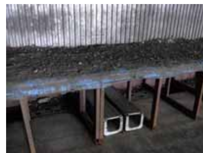
冷機取り込み口 (4か所の取り込み口に向けて雪にトンネルを空けておく)
