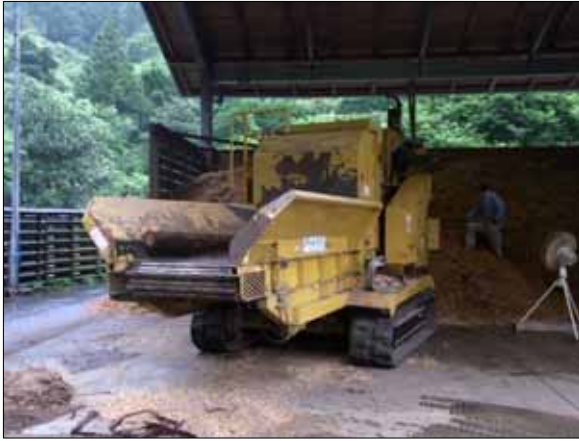
破砕機の後方から材料を投入する
