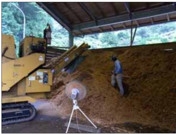
破砕された材料は前方のベルトコンベアから収納庫へ集積される
