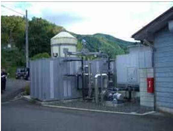
栲原中学校に導入されているペレット焚きアロエース
