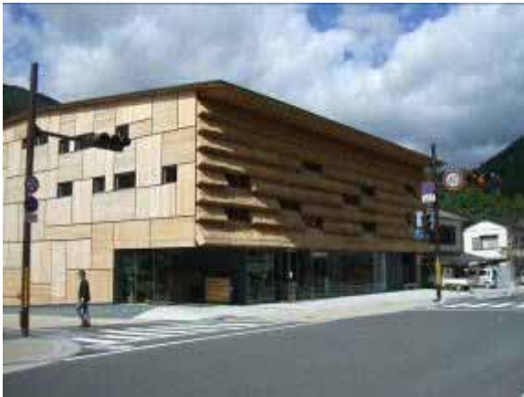
栲原町総合庁舎。 町産材の積極的な活用を推進している。
