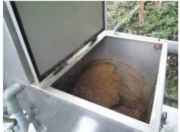
バイオマス(微生物)の作用による自然の生活排水浄化システム
