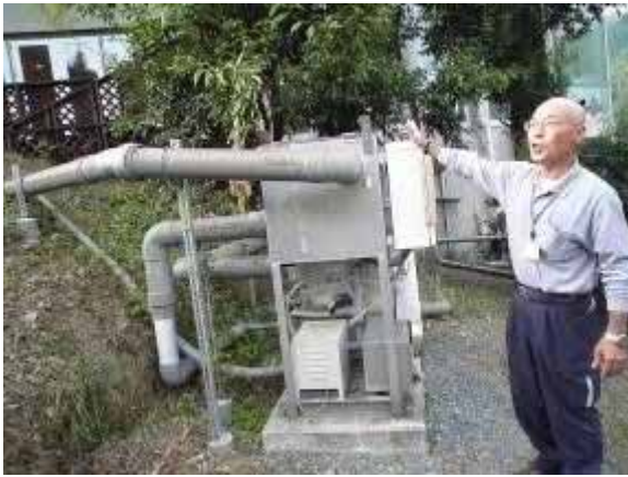
バイオマス(微生物)の作用による自然の生活排水浄化システム
