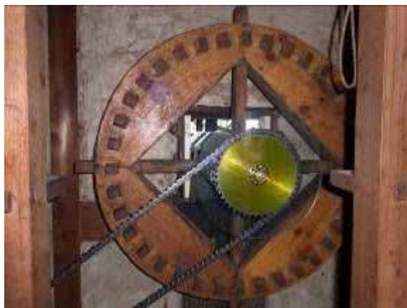
水車が回ると発電機が回って発電する仕組み
