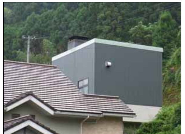
周囲の景観に配慮しトーンを落としたボイラー室の外装
