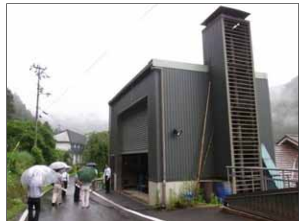
ボイラー室:側面にあるのは排煙塔
