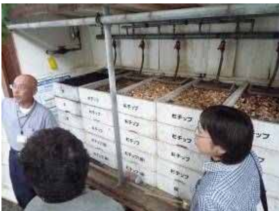
微生物により浄化された水は臭いもほぼなく、貸しコテージのお手洗で活用
