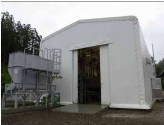
テントで覆われたプラントの全景
