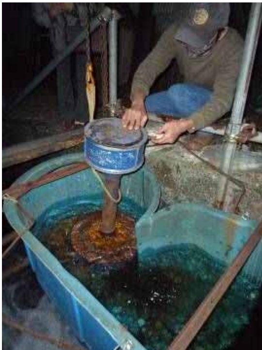
視察時は外されていたが5分程度で設置された
