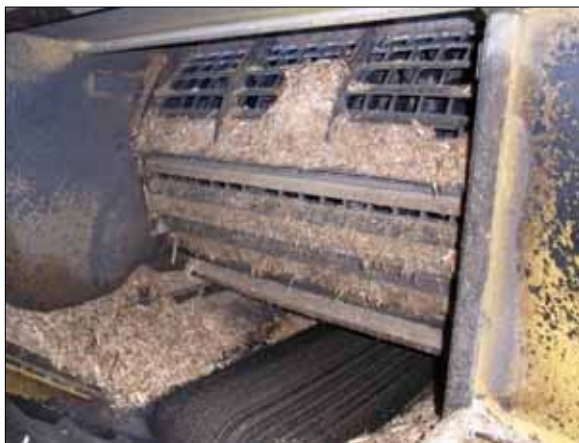
破砕室出口:ここからチップが吐き出される
