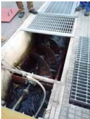
川上ミニ水力発電(水車部分)
