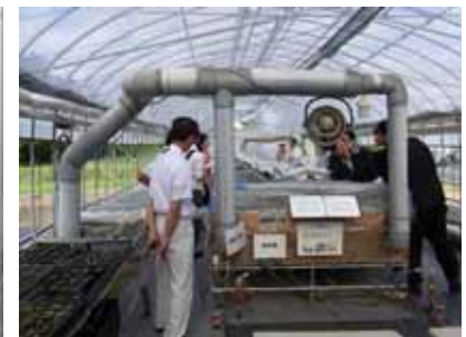
コンテナ式貯雪庫からの送風施設
