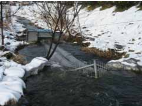
若干水が引き安定してきた堰の様子(12/8)
