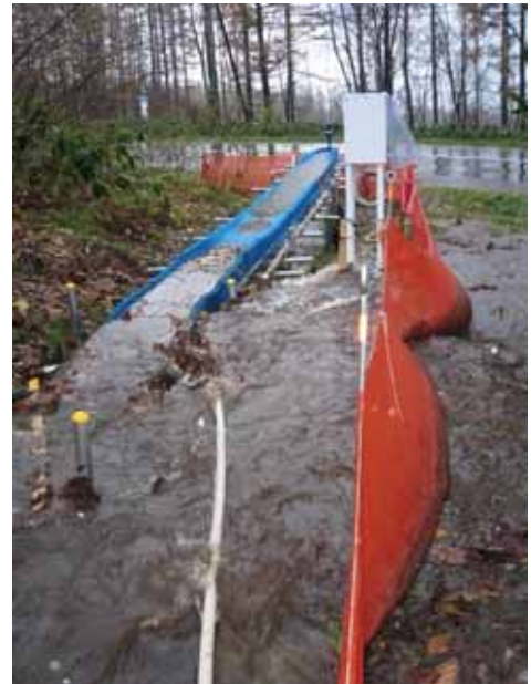
導水路が堰となり用水が氾濫する状態となった (11/10)
