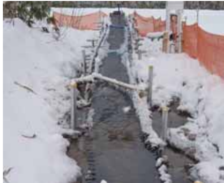
周囲は積雪するが導水路は水面が露出している (12/9)
