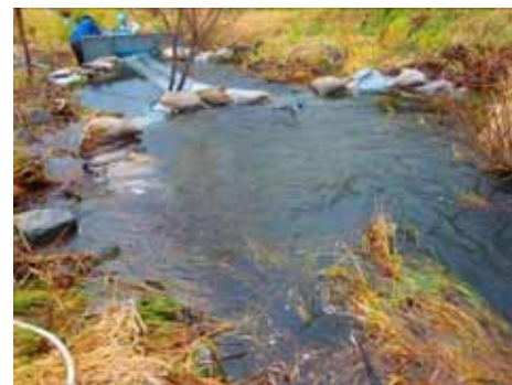
土のうの修復が完了した様子 (11/14)
