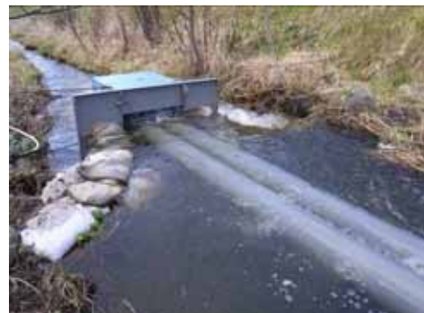
導水管の上面まで増水した用水 (11/23)
