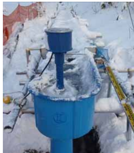
水槽内は用水が凍結し水車は停止状態となっている (12/12)
