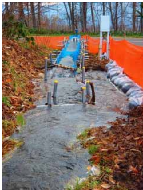
土のうを積み護岸の保護を行った (11/13)
