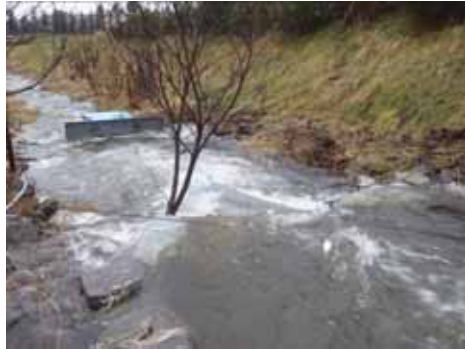
降雨により増水し氾濫状態の河川(12/4)
