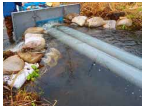
水車の点検を兼ね土のうの修復を行った (11/14)
