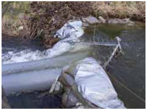
上流側の堰からもオーバーフローが見られる (11/23)
