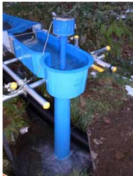
管の設置が完了した様子(10/28)
