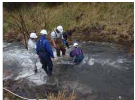
流失した土のうを拾い上げ修復を行った(12/4)
