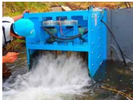
水車の受軸の点検を行う (11/14)
