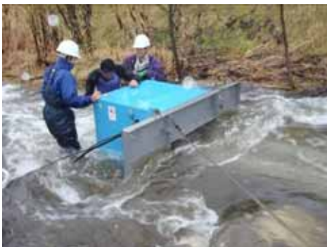
増水によって水車に破損が生じていないか確認を行った(12/4)
