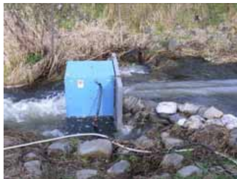
若干は水が引いたがまだ側面からのオーバーフローが見られる (11/23)
