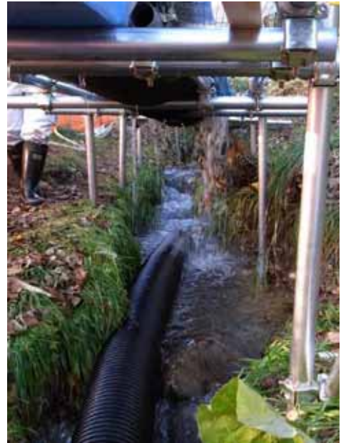
気泡を低減する管を設置(10/28)
