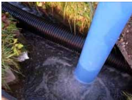
管を設置し外部からの気泡おさまった様子(10/28)
