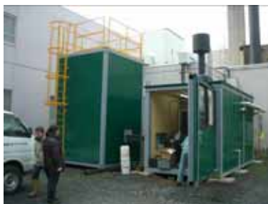
仮設のチップ貯蔵庫(左) とボイラー室(右)
