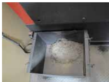
燃焼炉脇の灰蓄積部
