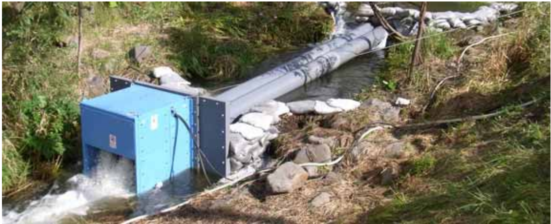
導水管の設置を行った
