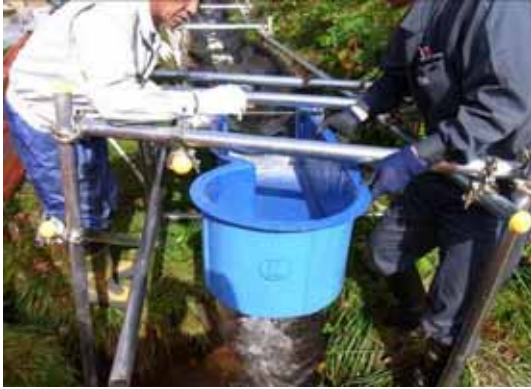
水車の設置作業
