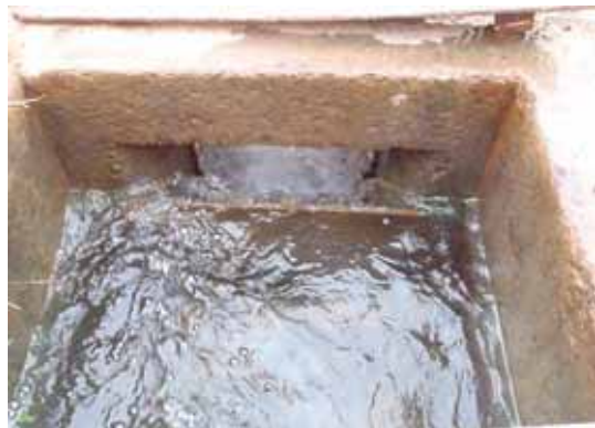
嵩上げ壁設置後の集水枡
