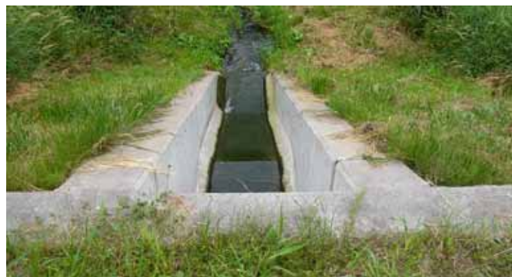
下水処理場の排水口の状況
