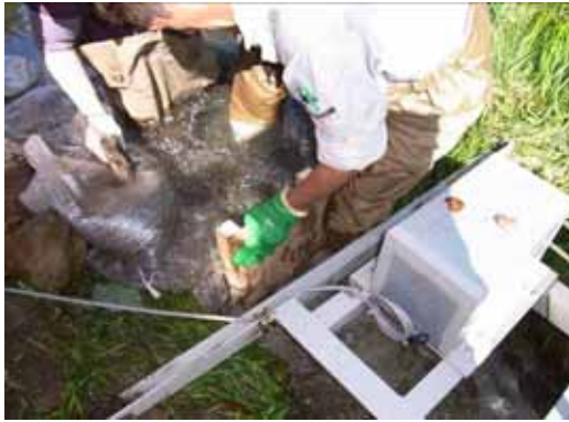
土のう前部に板材を設置した
