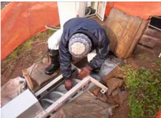
落葉の除去作業
