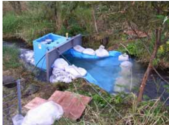
水車の設置完了
