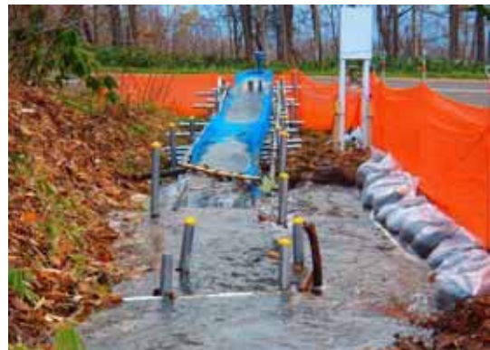
土のうを積み護岸の保護をおこなった
