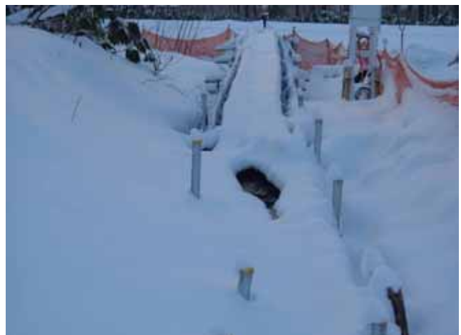
導水路も凍結したことにより水量が減少し、発電機が
