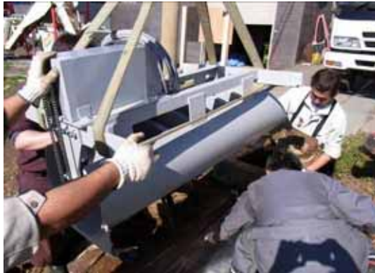
設置場所を確認し水車の設置を行った
