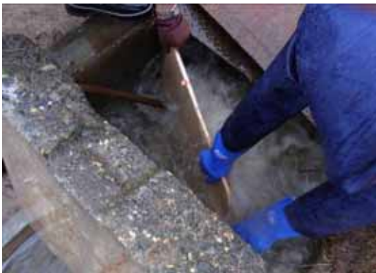
落水エネルギー増加のため上流側の集水枡に 嵩上げ壁を設置
