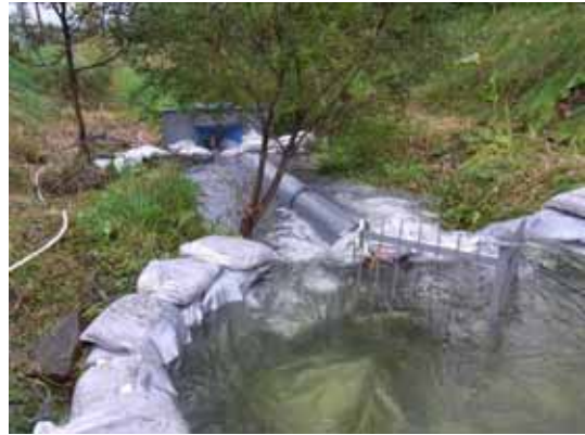
上流側に第二の堰の設置をおこなった
