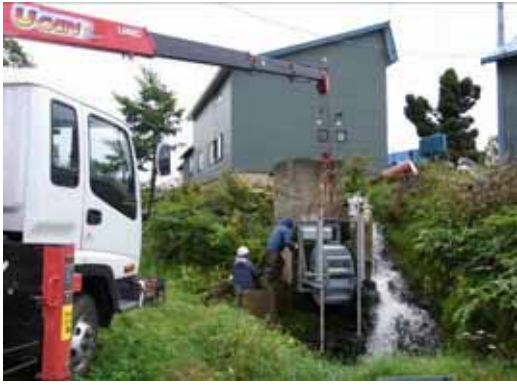
既設コンクリート躯体に水車本体を固定
