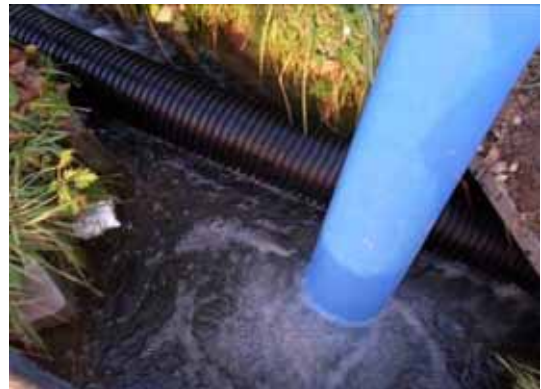
管を設置し外部からの気泡がおさまった様子
