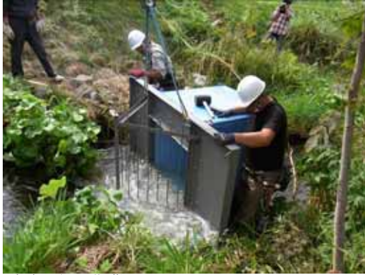
水車の設置作業
