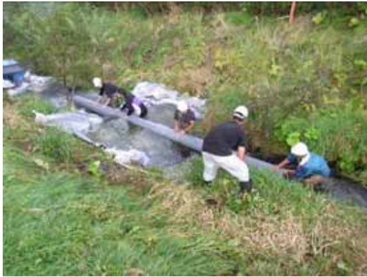
導水管の設置作業
