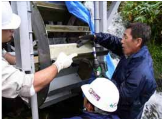
用水が溜まるように羽根の改良を行った
