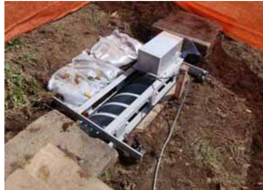
水車の設置が完了
