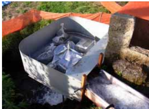
導水路の落水口に加工した防水シートを設置
