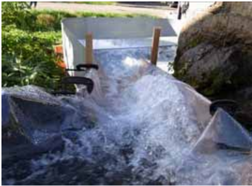
導水路からプールへの流水状況
