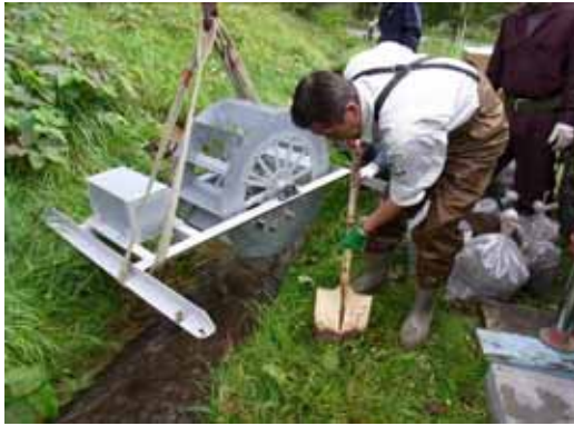
水車設置作業
