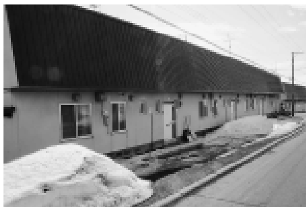
本年度全面改修工事を実施する本通A団地
