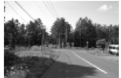
歩道整備と舗装改良工事を行うニセコ登山道路
