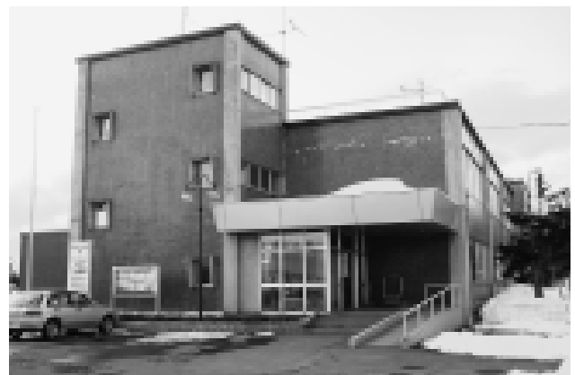
建築後42年が経過した役場庁舎の状況も診断します
