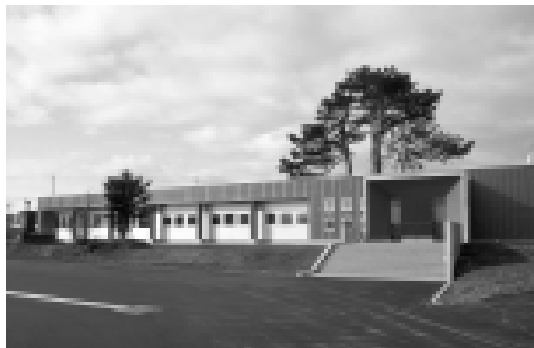
平成20年度に完成した曾我活性化センター
