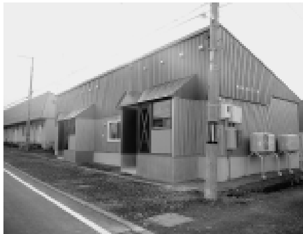
昨年度全面改修工事をした本通A団地
