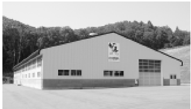
一般廃棄物最終処分場
