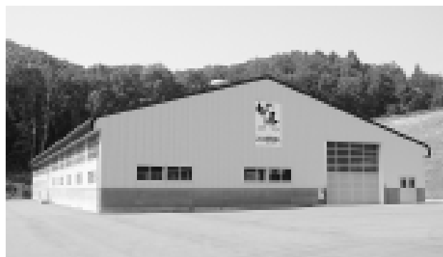
一般廃棄物最終処分場
