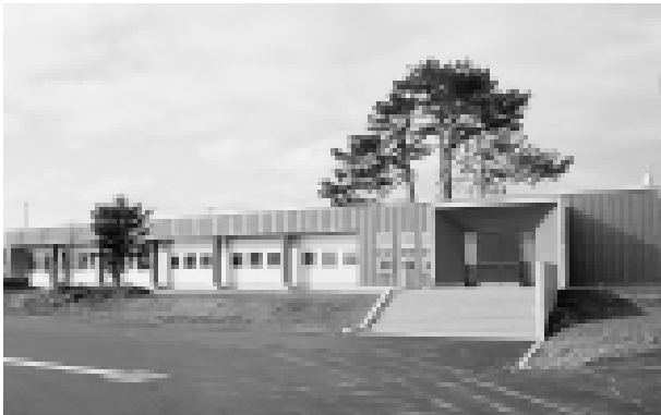
北栄・東山・滝台・西山地区の集落再編に伴い、地域活性化の拠点施設として、曾我活性化センターが完成しました
