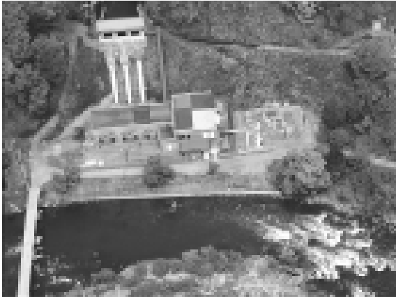
空から見た尻別第一発電所 手前は尻別川
