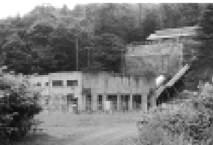
尻別第二発電所
