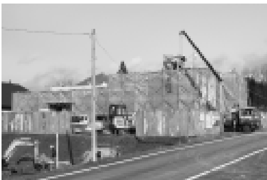
建設中の給食センター
