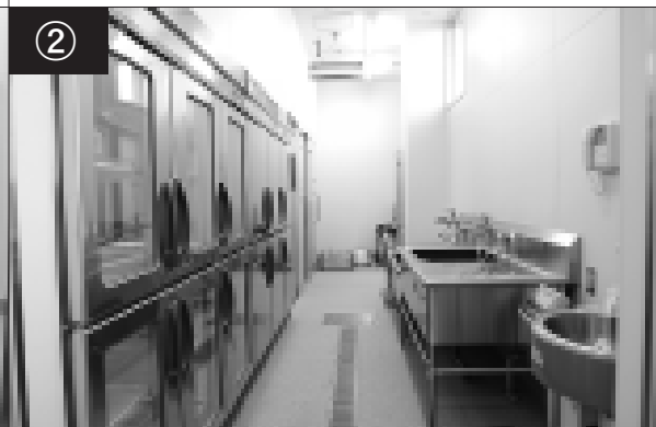
② 検収室 業者から納入された食材を、専用の容器に入れ計量する。計量した食材は写真左の前後両面に扉がある冷蔵庫（パススルー冷蔵庫）などを通して下処理室へ移す
