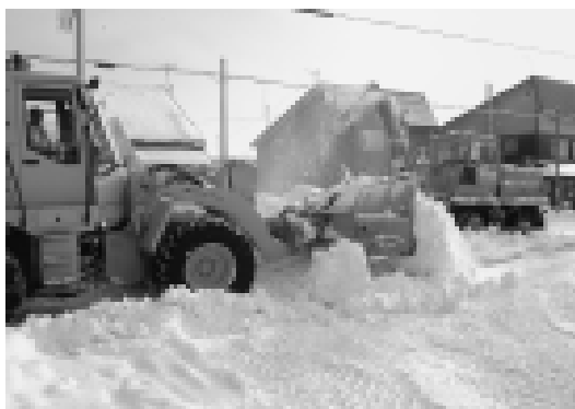
町道の適切な除排雪により、冬期の安全で快適な生活環境を確保します
