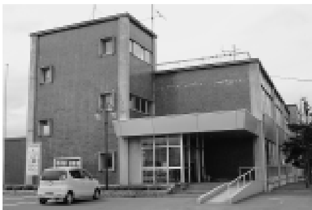
役場庁舎などの公共施設について計画的な維持補修を行い、長寿命化を図ります
