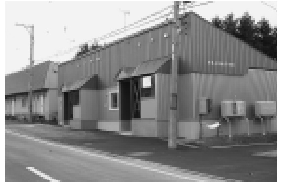
本通A団地の全面的改善工事など、公営住宅の計画的な改修を進めます
