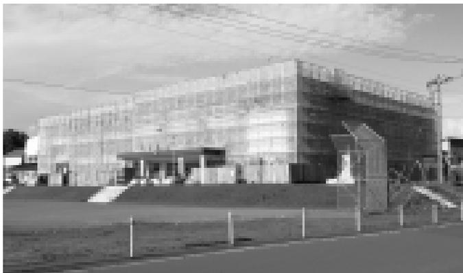
ニセコ小学校では、校舎屋上の断熱防水工事や外壁のひび割れ補修、教室の壁・天井など内装の更新工事を行っています
