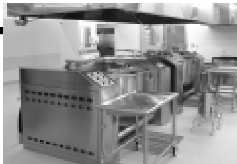
給食センターでは厳しい衛生管理のもと、安心安全な給食を提供していきます
