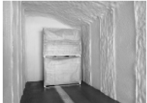
大道農園では農作物の貯蔵を雪氷冷熱を利用した倉庫で実証実験が行われています
