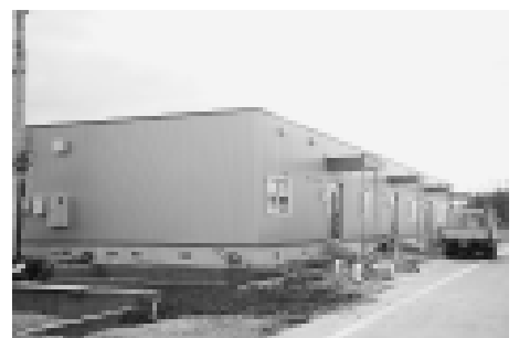
教員住宅の建替工事
