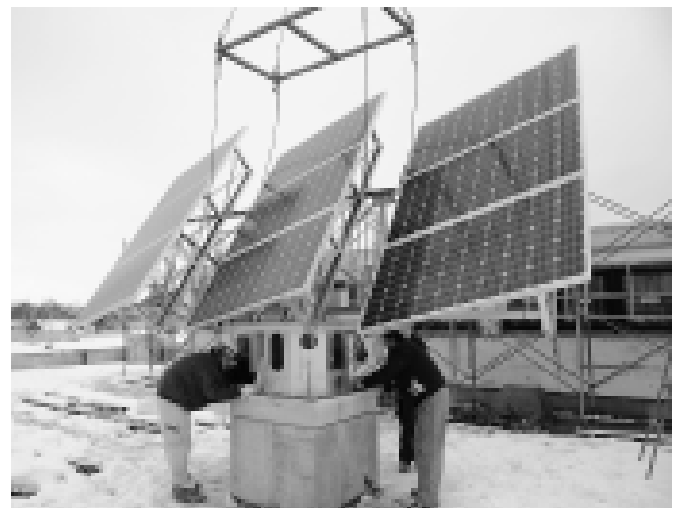
追尾式ソーラーパネルはクレーンで吊り上げられて、町民センターの屋上に設置されました
