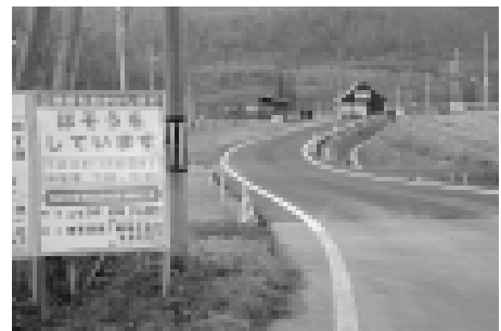
町道北栄会館通の改良工事
