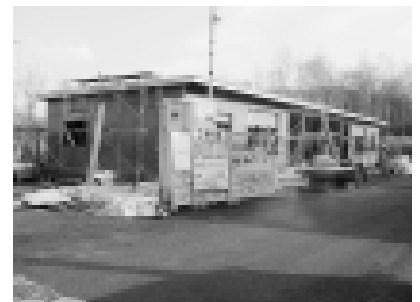
建設中の西富団地
