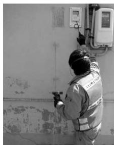
(写真1) 地下に埋設された水道メーターに伝わる振動音で漏水を確認します
