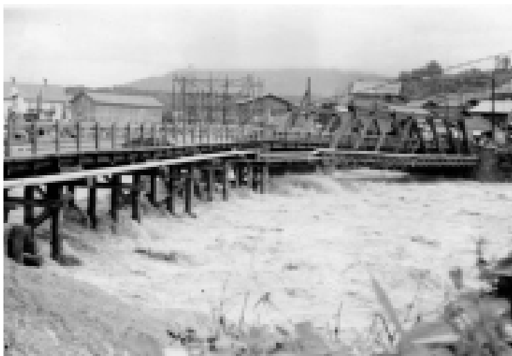
仮設工事中の芙蓉橋の様子 (芙蓉橋は昭和37年8月3日に台風9号によって流されています)
