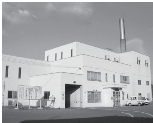
平成14年からニセコ町の燃やすごみを処理していた倶知安町の焼却施設
