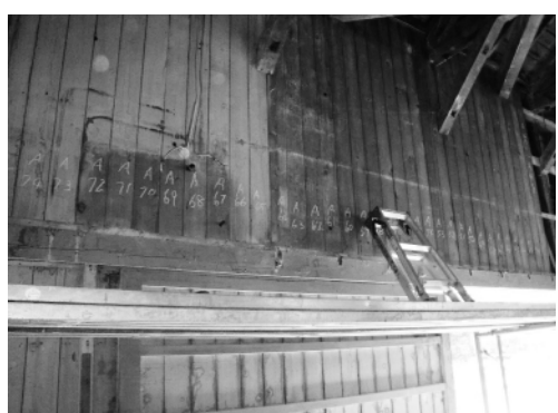
壁の板材は取りはずす前に番号をつけています。壁に断熱材を入れた後、再び順番どおりに板材を取りつけます
