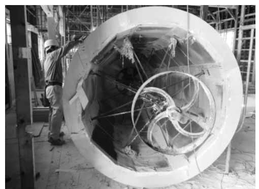
「ふるい」は、建物内に鉄骨フレームを組んだ後で、その上に乗せて固定し、でんぷん加工の歴史のシンボルとして保存します
