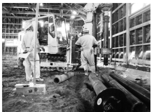
建物を支えるための杭（手前の円柱）を地面に打ち込んでいきます
