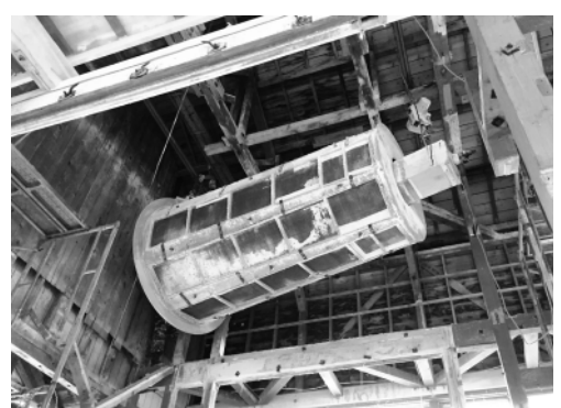
天井を撤去して現れた、でんぷん加工のための巨大な「ふるい」。壊れないよう慎重に下ろしていきます
