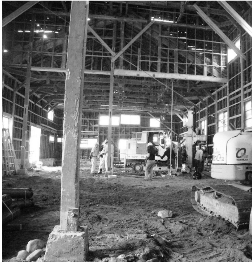
2階部分と階段、1階の床や天井を撤去し、壁の板材を全て取りはずしたところ。骨組みや物内に鉄骨でフレームを組み、建物を支えます
