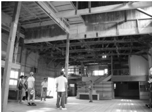
工事前の旧でんぷん工場内部
