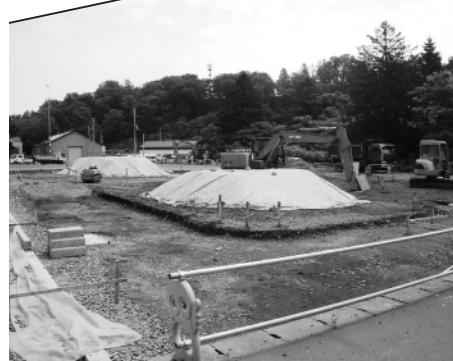
地をした後、広場の周囲を舗装するための準をしてしています。舗装の内側は芝生になります
