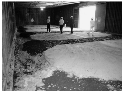
旧でんぷん工場と同様に、建物内に鉄骨でフレームを組み上げます。そのため、フレームが通る部分の土間を撤去しています
