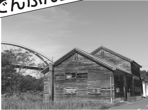
木造一部2階建てで、建物内にでんぷん加工の設備が残されています
