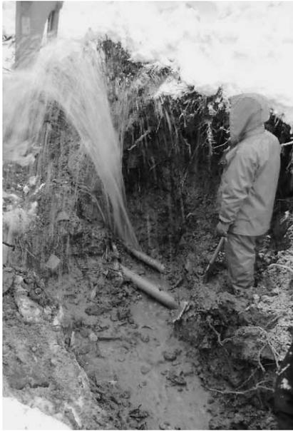
本年度発生した水道管破裂事故のようす。老朽化が進むと破損の可能性が高まります
