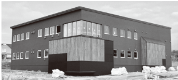
建設作業中のモクレニセコA棟 (10月末に撮影)
